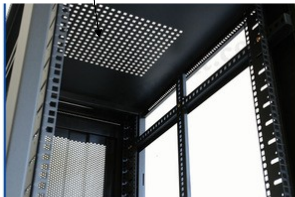
Пасивна вентиляція в дверях шафи
